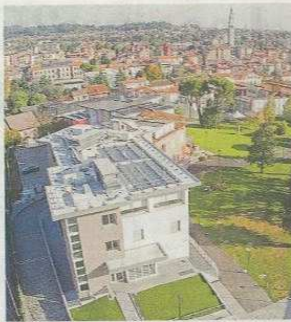
La casa di riposo si presenta con spazi rinnovati
